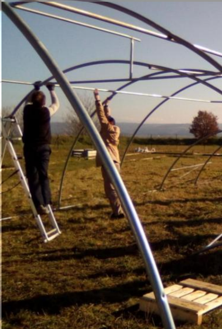
Photo AFdP : montage de la serre au jardin Graines de Paradis à Manosque
