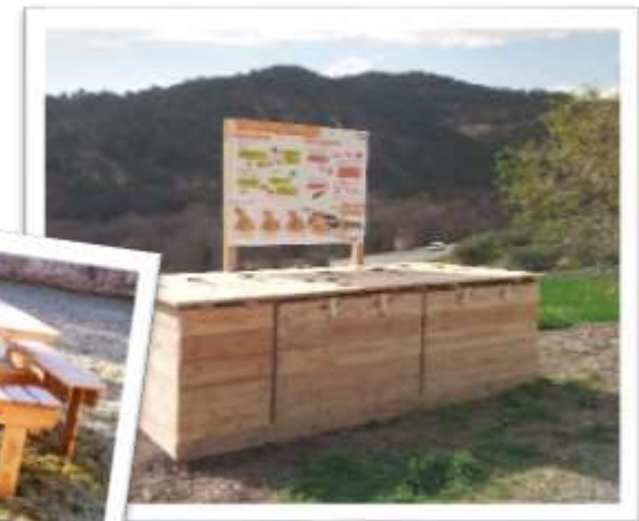
Conception et mise en place de plateforme de compostage
