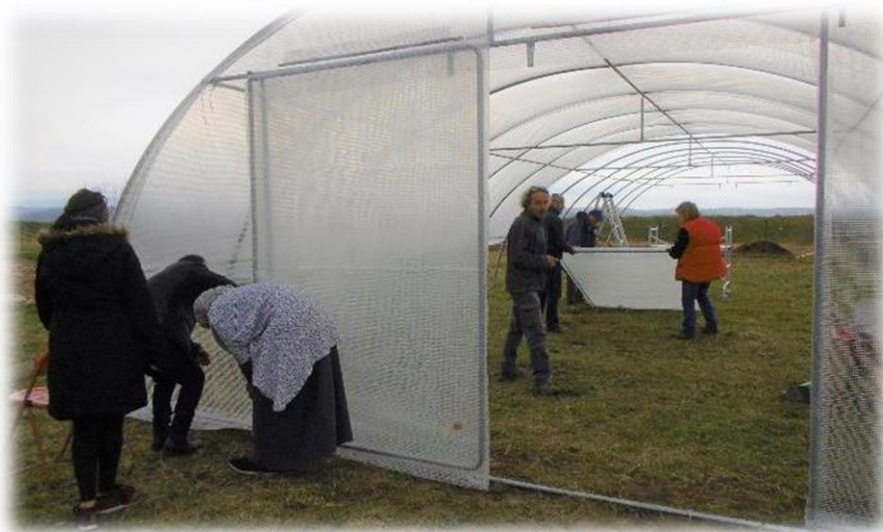
Pose de la bâche de la serre à Graines de Paradis
