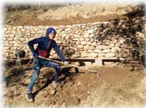
Mur de soutènement en pierres sèches et ré-engazonnement dans des jardins privés
